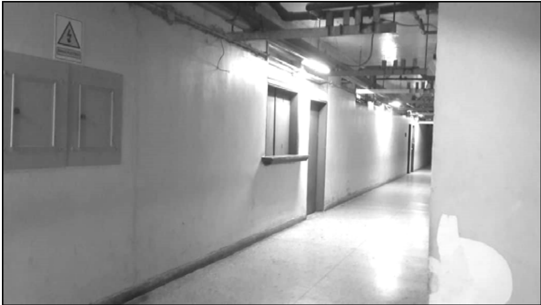
Techo entre el Servicio de Cardiología y Fisiatría
