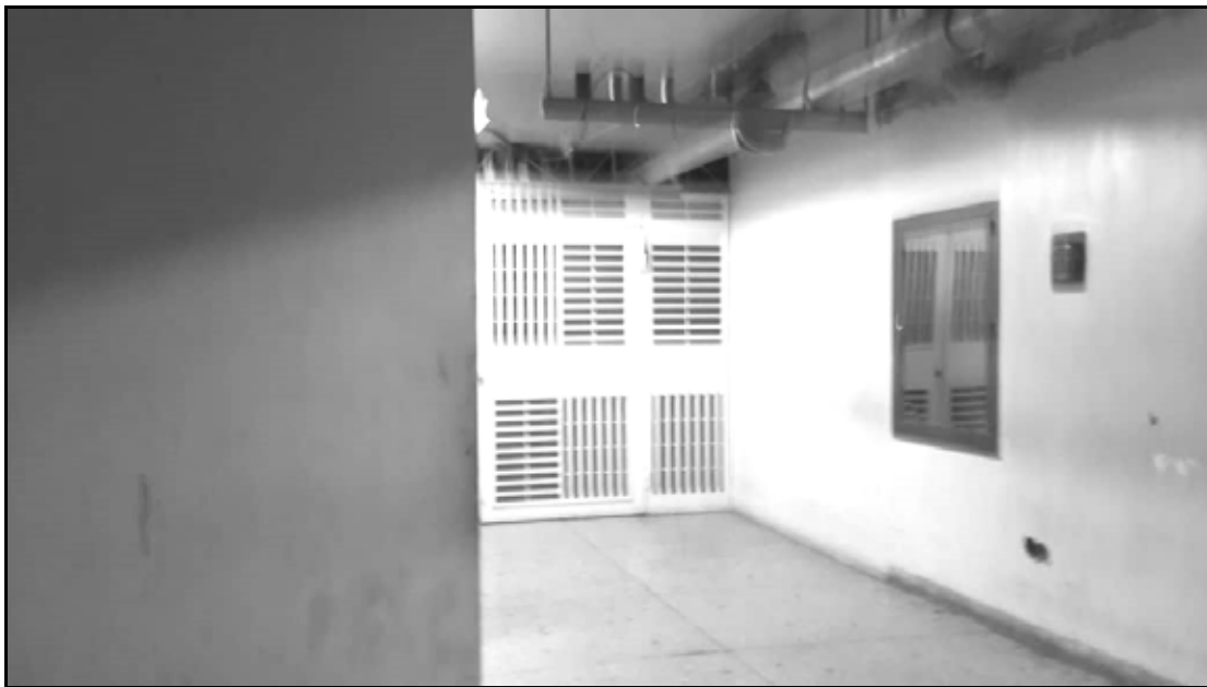
Techo de Fisiatría
