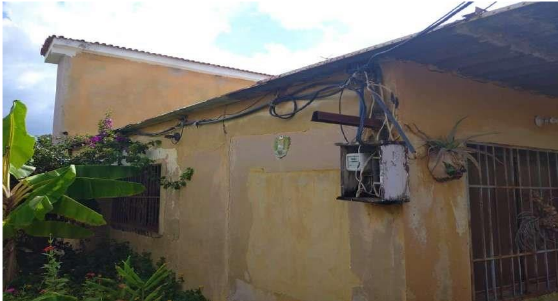
Figura 8: Ejemplo de entrada interna de la línea de cobre de CANTV. Fuente: Balza, Figueroa (2021).
