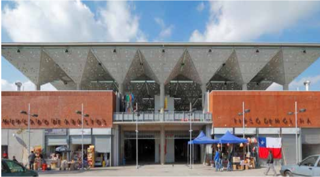
Figura 3: Fachada principal del mercado municipal tirso de molina. Fuente: http://www.plataformaarquitectura.cl/cl/02-104707/mercado-tirso-de-molina-iglesia-prat-arq (2011).
