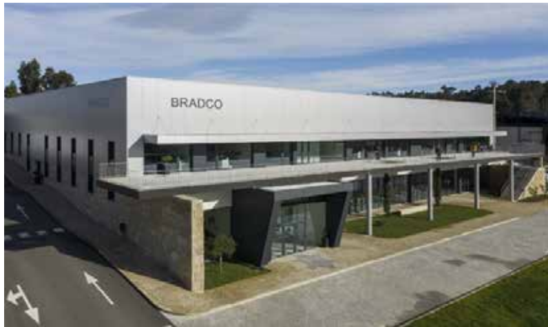
Figura 2. Fachada del edificio Bradco. Fotografía por Ivo Tavares Studio (2020)
