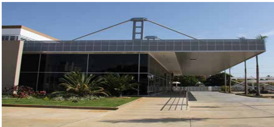
Figura: 9. Autor: Nones Eduardo y Nones Enrique. Galería. Centro de Inspección Seguros Catatumbo. (2004)
