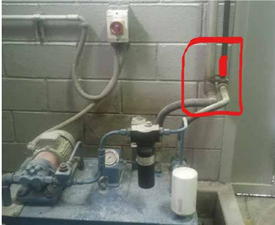
Figura 51. Ubicación para la instalación del interruptor de flujo.
