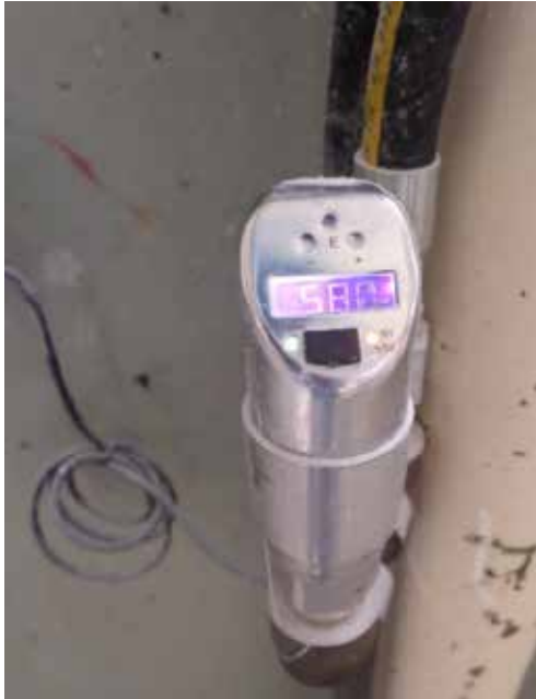
Figura 18. Transmisor indicador de presión de los laminadores.
