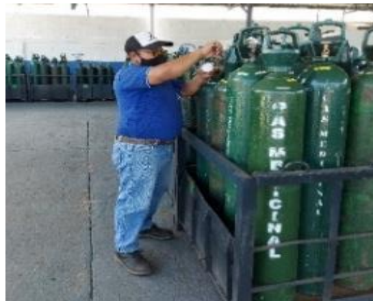
Figura 3. Revisión manual de tanques estacionarios Fuentes: Saez, G (2022)
