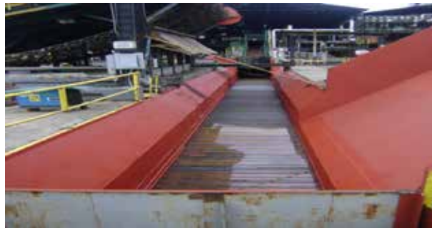
Figura 10. Rampa de descarga y conductor 1.
