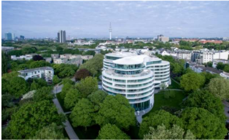
Figura 3 Vista del Hotel TheFontenay.
