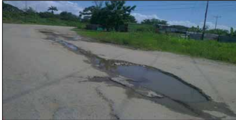
Figura 35. Bache de gran tamaño y Descascaramiento Fuente: Francisco González (2019)
