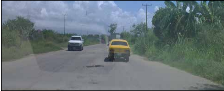
Figura 47. Bache, piel de cocodrilo y Grieta Fuente: Francisco González (2019)
