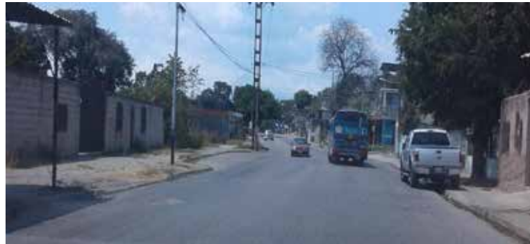
Figura 54. Grietas y Baches
