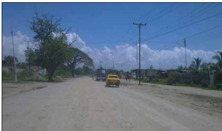
Figura 40. Pérdida total del pavimento Fuente: Francisco González (2019)
