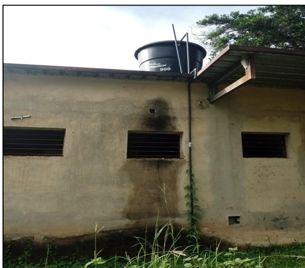
Daños en el techo y paredes debido a las filtraciones. Mejia y Moreno (2022).
