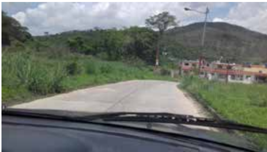
Figura 21: Entrada hacia la urb. Lomas de la hacienda.
