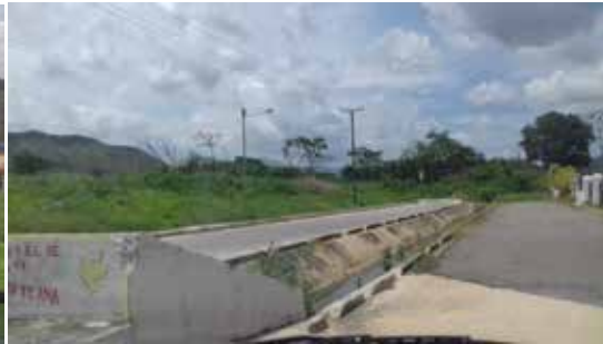
Figura 22: Vista desde entrada de Urb. Lomas de la Hacienda.
