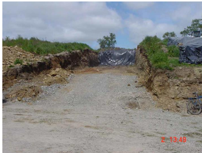
Figura 21. Silo de tipo trinchera (foto real)
