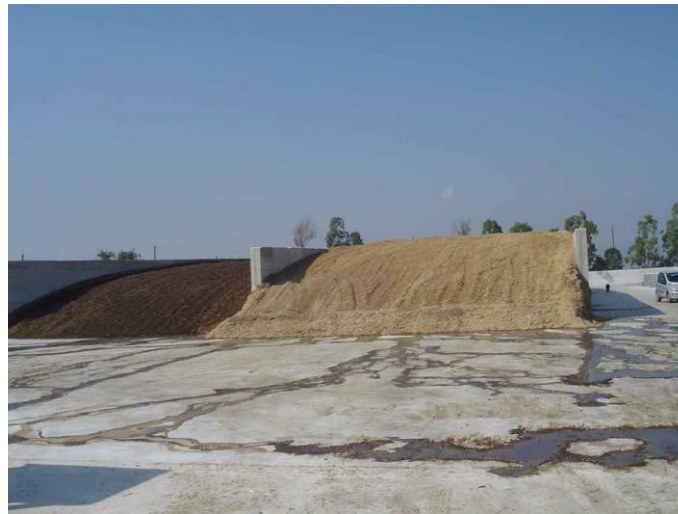
Figura 23. Silos de tipo canadiense (Foto real) Fuente: Filippi,R.(2006)
