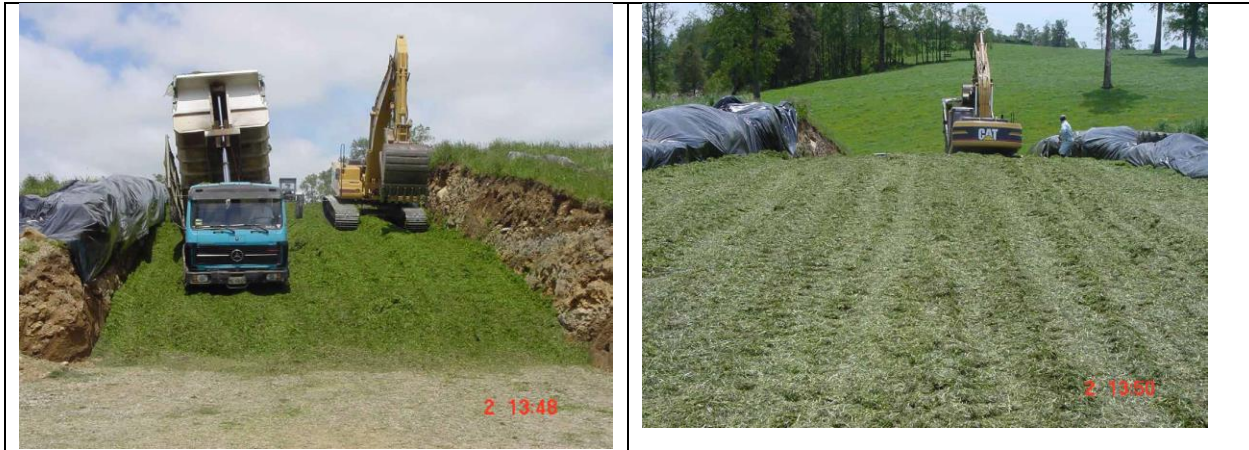
Figura N°26. Llenado de silo y compactación
