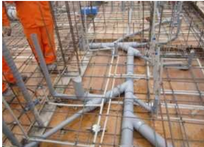
Figura 85. Instalación de Aguas servidas. Fuente: http://csedificaciones.com/instalaciones-sanitarias/ (2015)
