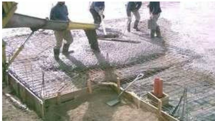
Figura 83. Losa de Fundación. Fuente: http://www.construmatica.com/construpedia/Cimentaciones_por_Losa
