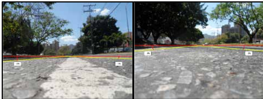
Figura 20. Pendientes de Bombeo Sentido Noroeste / Sureste
