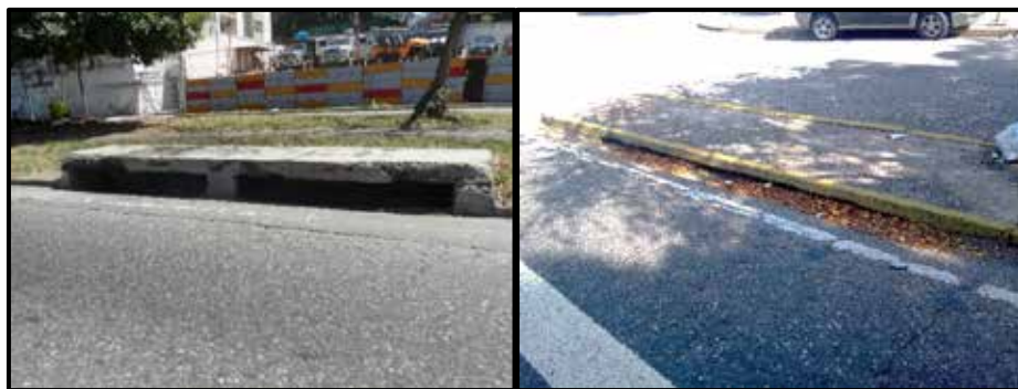
Figura 18. Sumideros de Ventana Av. Cuatricentenaria
