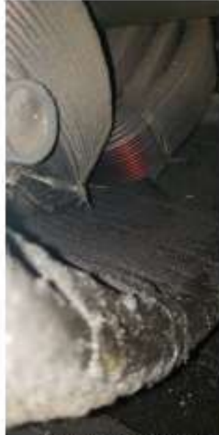
FOTO N°2, EXCESO DE ACEITE
