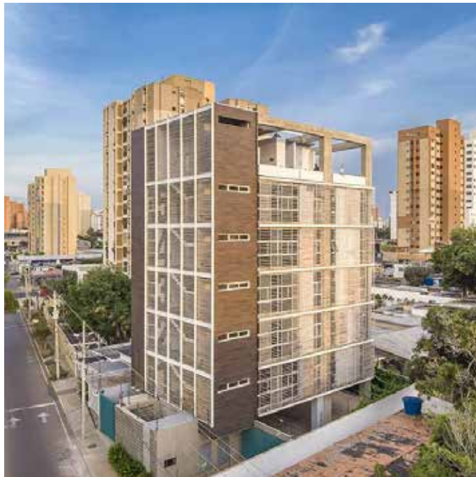
Figura 3: Residencias Sei . Arquitectura Venezuela (2017).
