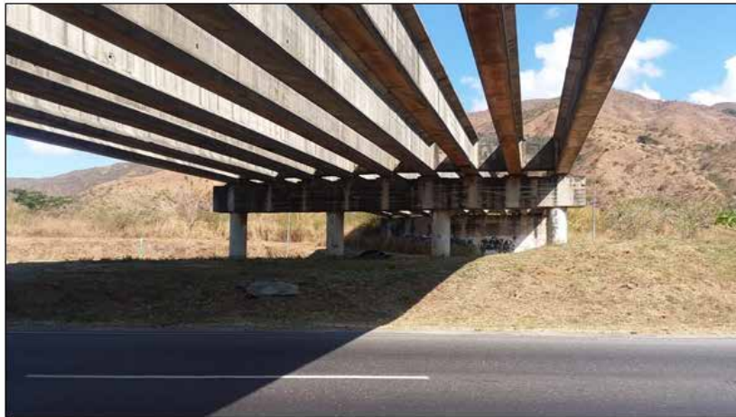
Figura 23. Vigas de un tramo del puente olvidado
