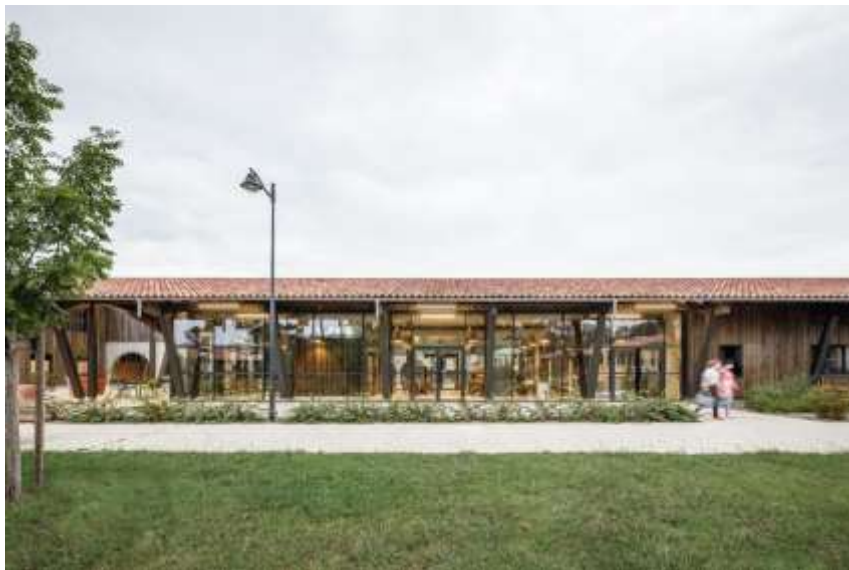
Figura 6. Fachada, Centro para la tercera edad. 2020
