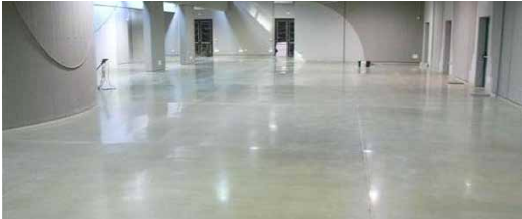
Figura 51. Acabado de granito pulido en pisos de la edificación. Fuente: www.admasarquitectura.com
