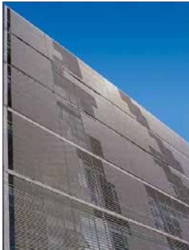
Figura 23: Celosías Hunter Douglas. Fuente:
