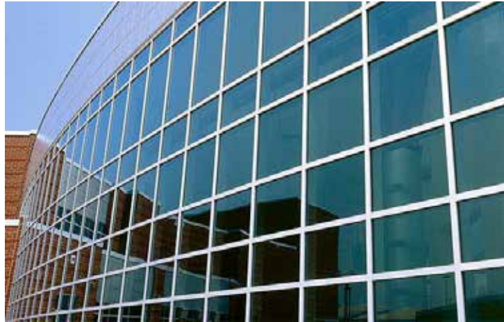
Figura 74 - Muro cortina. Fuente: http://img.archiexpo.es/images_ae/photo-g/51651-2134979.jpg . (2016)
