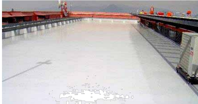
Figura 57 - Losa con impermeabilizante acrílico. Fuente: http://articulo.mercadolibre.com.ve/MLV-458141341-impermeabilizante-acrilico-deco-roof-azul-blanco-y-gris-_JM . (2016)
