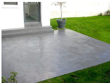
Figura 23, Acabado de piso Concreto Pulido https://casa-web.com.ar (2022).
