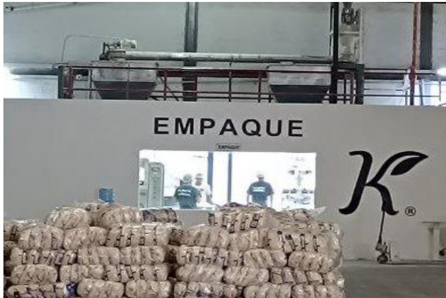
Figura 6. Vista desde el pasillo central de la ubicación de las Tolvas sobre la sala de Empaques
