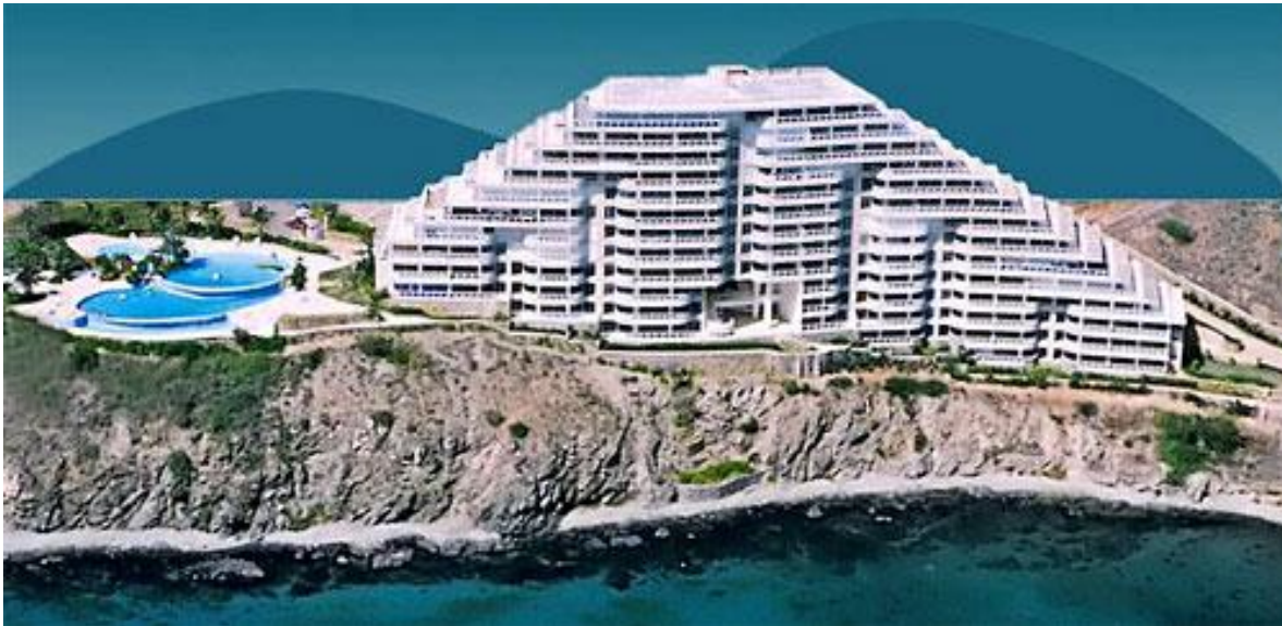
Figura 3: Hotel Residencias Morro de La Mar Fuente: https://www.arquitzvla.com (2015)
