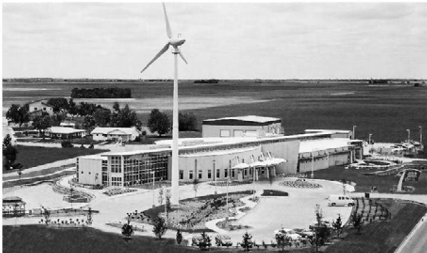
Figura 4 Kiowa county memorial hospital. Fuente: http://ecologismos.com/greensburg-la-ciudad-mas-ecologica-de-estados-unidos/ (2015).
