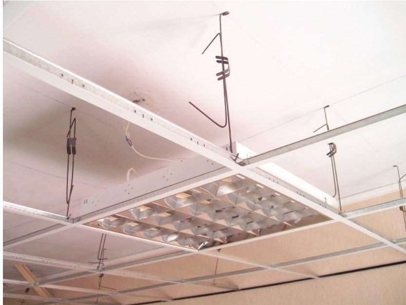
Figura 8. Techo falso. Fuente: www.reformaster.es
