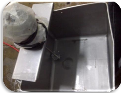
Figura 8 Tanque de Preparación de la Salmuera
