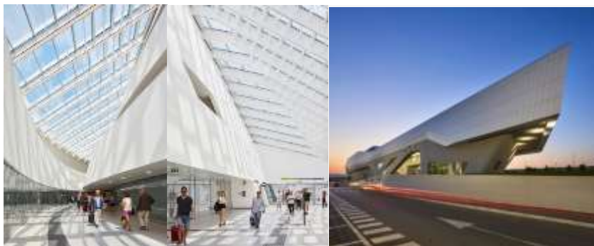
Figura 6: Estación Napoli Afragola, Italia.
