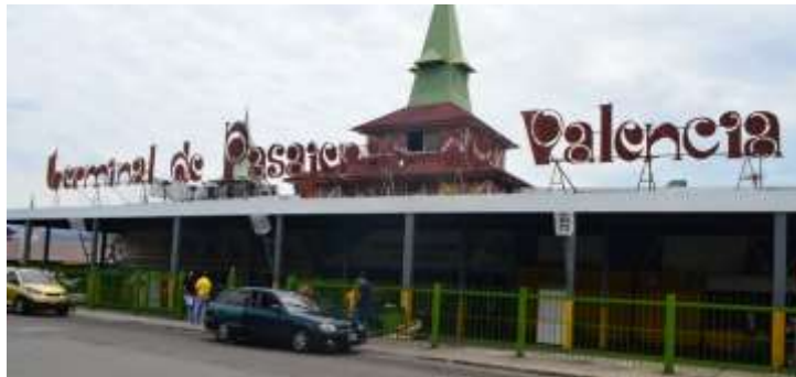
Figura 15: Fachada del Terminal de Pasajeros de Valencia.
