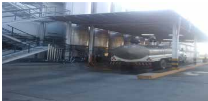
Figura 3: Área de Recepción de la Cisterna
