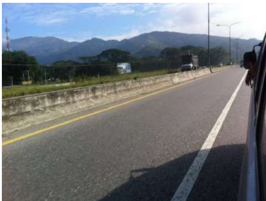
Figura 36 Separador de concreto tipo new jersey
