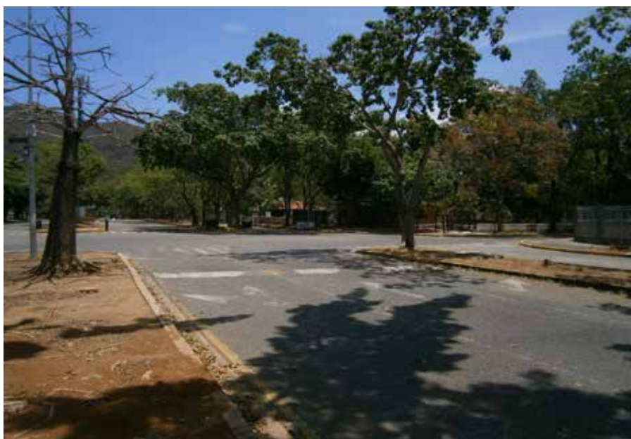
Figura 25. Calzada en sentido Norte-Sur en Las Cuatro Avenidas.
