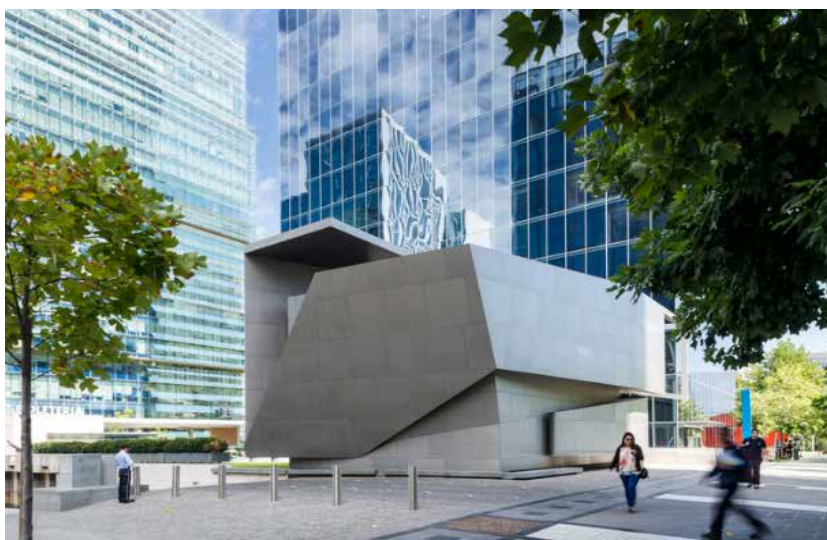
. Centro Cultural CopArtes. Plataformaarquitectura (2017).
