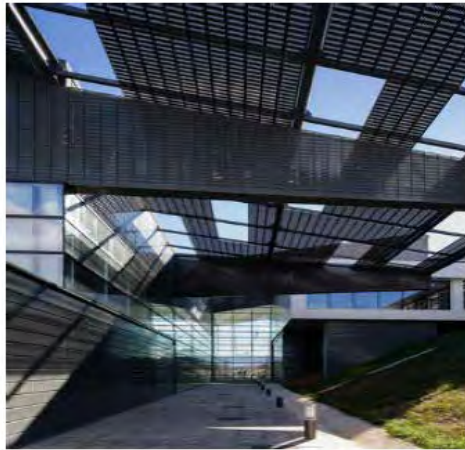
Figura 10 Detalle cubierta Fuente http://www.plataformaarquitectura.cl/cl/02-330712/la-estacion-de-alta-velocidad-de-villena-cootar/52e71f3be8e44e081d00025a (2013)
