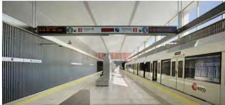
Figura 4 Vista Interna Andenes. Fuente:
