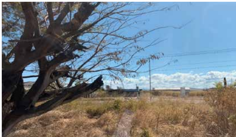
Figura: 22. Inspección Visual desde La Autopista Regional del Centro (3). Fuente: Inspección Visual, Gutierrez A. y Perrone A. (2020).
