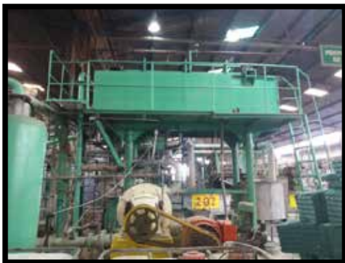
Figura 12 Clarificador DAF. Fuente: Bruguera F. (2020).
