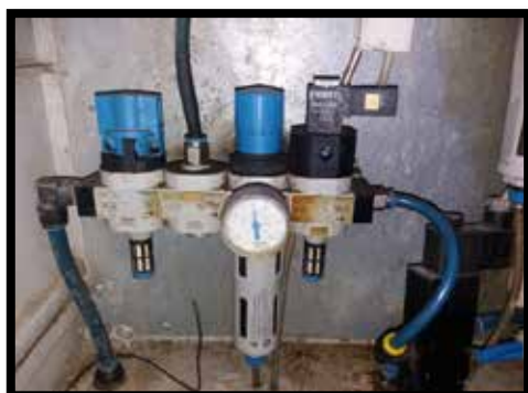
Figura 40 Indicador de presión de entrada de aire del Krofta.
