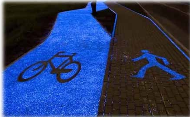
Figura 7: Fotoluminiscente en carreteras, aceras, pistas deportivas, plazas, etc.
