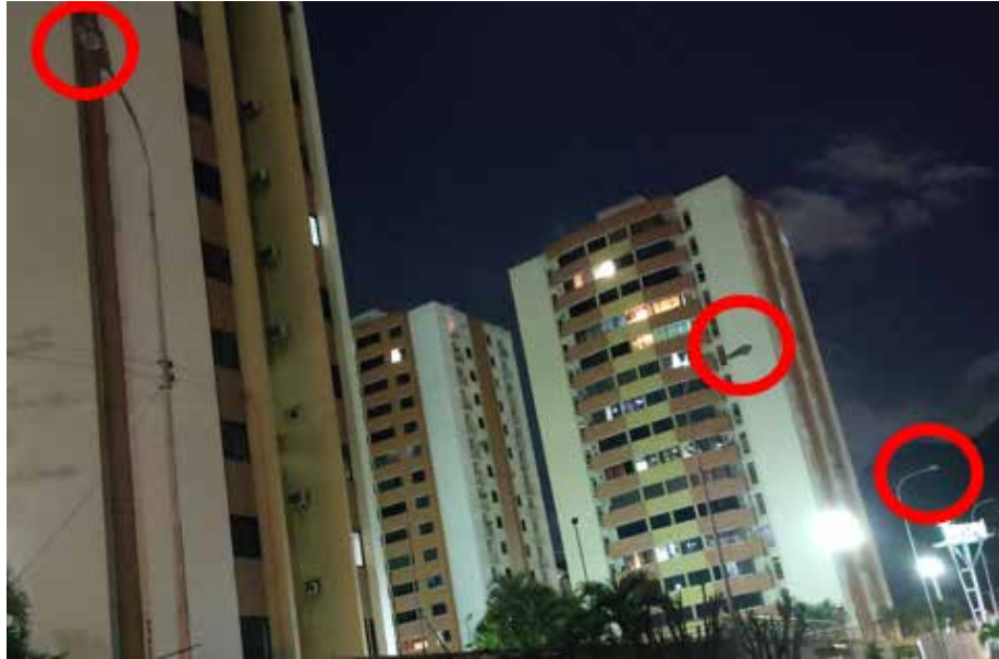
Figura 60: Poste N° 6,7,8 Luminaria no encendida Calle 1. Fuente: Cuenca C. (2021).
