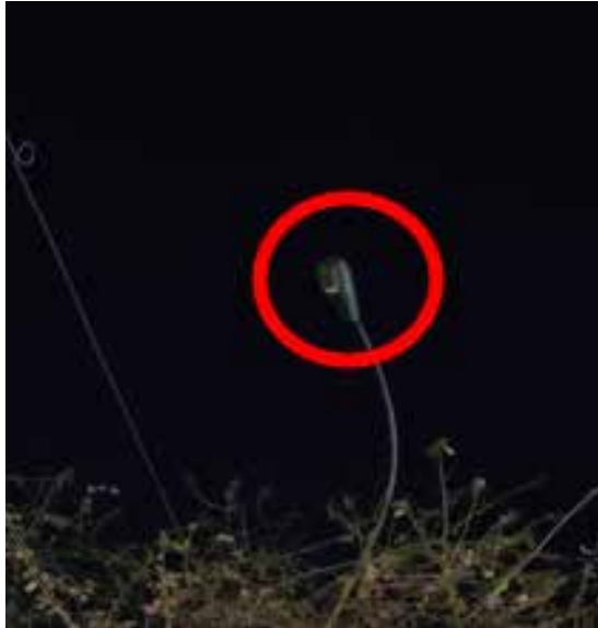
Figura 62: Poste N° 1 Luminaria no encendida en la Av. Norte-Sur 3. Fuente: Cuenca C. (2021).
