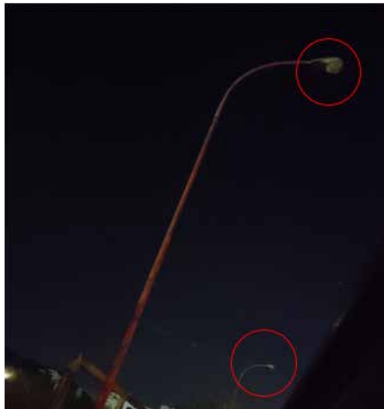
Figura 67: Poste N° 4,5 Luminaria no encendida en la Av. 3. Fuente: Cuenca C. (2021).
