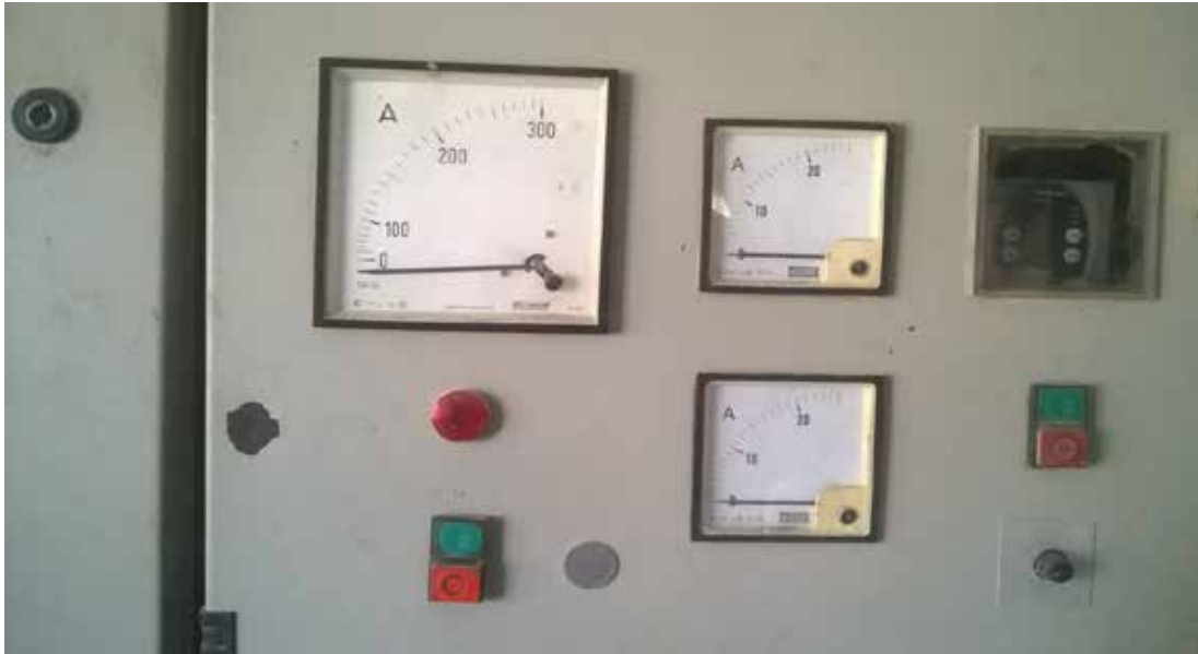
Figura.36. Indicador de corriente del motor del molde de la maquina peletizadora de la empresa Alimentos lagunita Carabobo
