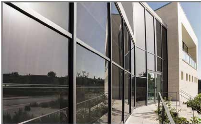
Figura 63. Fachada de Muro Cortina de Paneles de Vidrio Fotovoltaico. Fuente: http://www.onyxosolar.com/es/muro-cortina-fotovoltaico.html
