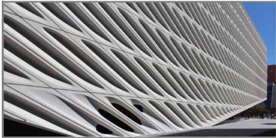
Figura 62. Fachada de Hormigón Reforzado con Vidrio, (GRC). Broad Museum. Fuente: http://www.pre-cast.org/gfrc_details.asp
