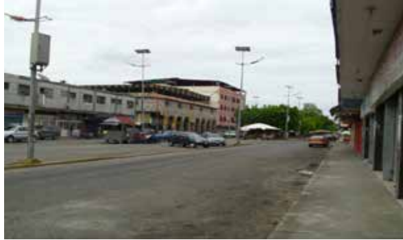
Figura N°41 Paneles Solares en la Av. Ricaurte.
