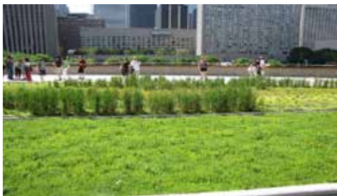
Figura N°47 Techo Verde en Toronto.
