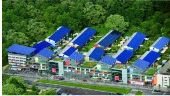
Figura N°42 Paneles Solares en Australia.
