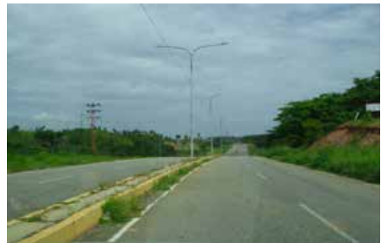
Figura N°7 Tramo vial “Che Guevara”.
