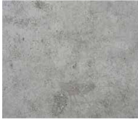
Figura 56. Concreto en visto.(2018)
