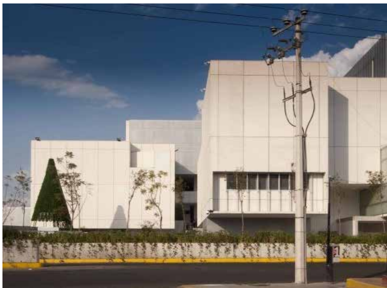
Figura 4: Fachada Sur. Fuente: https://es.wikiarquitectura.com/index.php/
