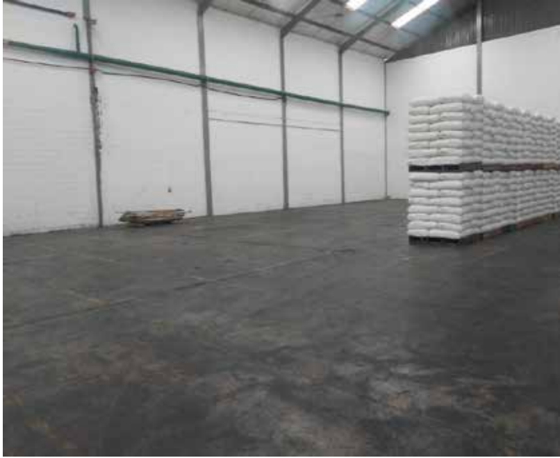
Figura 16. División 3. Equipos ubicados incorrectamente
