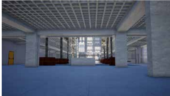
Figura 54. Vista de las losas reticuladas dentro de la edificación. (2020)
