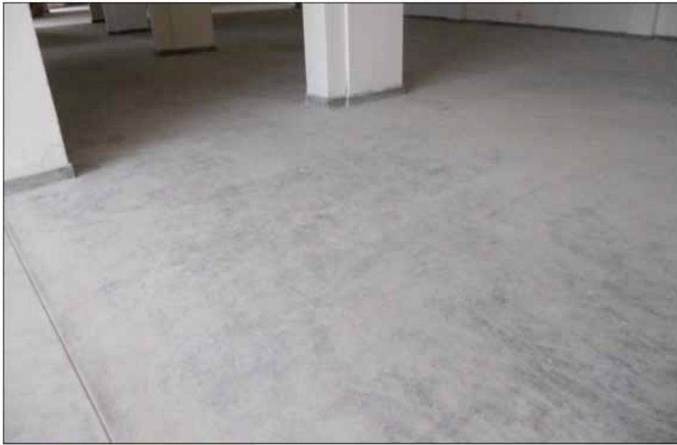
Figura 38: Acabado de piso rampa y área de carga y descarga. (2016).
