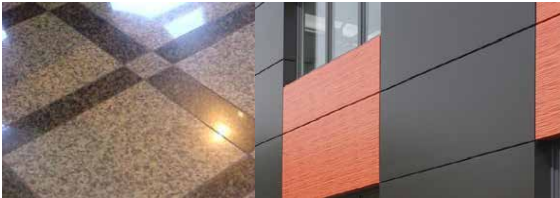
Figura 41: Acabado de piso granito de distintos colores / Alucobond como revestimiento. (2016).
