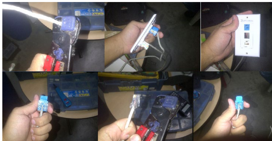
Figura N° 47: Montaje de Coupler RJ45, Jack RJ45 y faceplate
