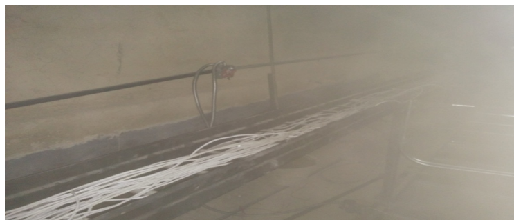
Figura N° 46: Proceso de tendido de cableado en la bandeja Fuente: El autor.
