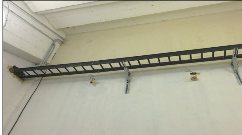
Figura N° 45: Bandeja utilizada como canalización Fuente: El autor.
