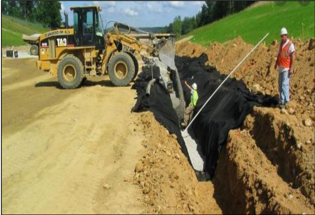
Figura 4: Drenes Franceses. Imagen referencial de sistema constructivo.
