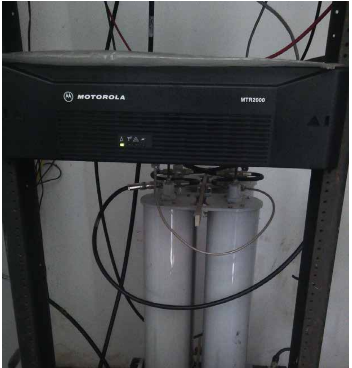
Figura 39: Montaje de la estación repetidora MTR2000 y el Duplexer Fuente: Lugo (2020)
