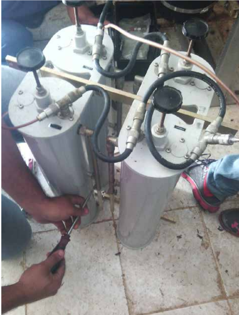
Figura 37: Calibrando las varillas que permiten rechazar la frecuencia Fuente: Lugo (2020)
