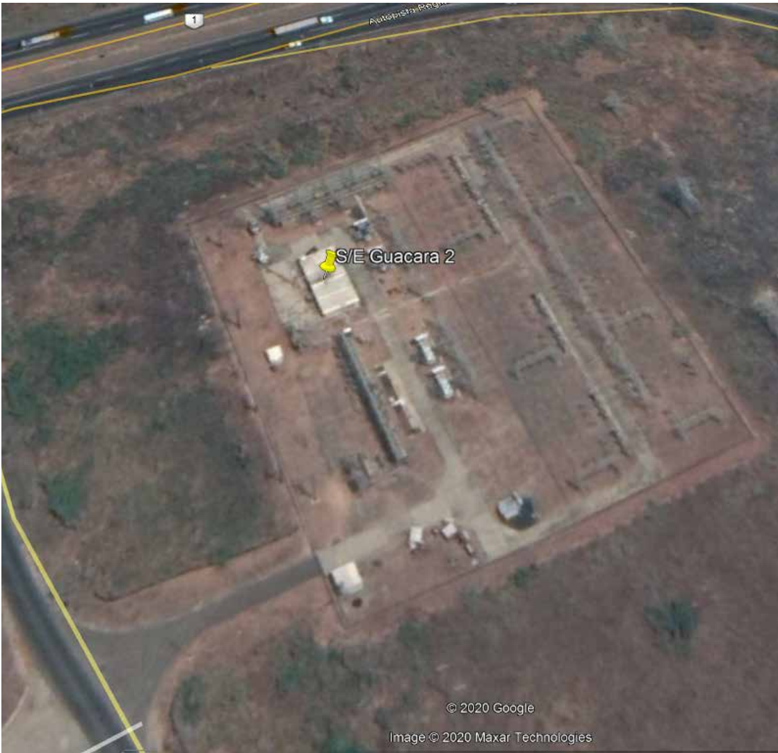
Figura 25: Ubicación geográfica de la subestación Guacara II Fuente: Google Earth (2020)
