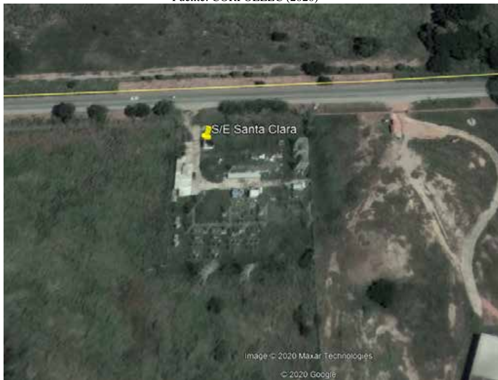
Figura 23: Ubicación geográfica de la subestación Santa Clara Fuente: Google Earth (2020)
