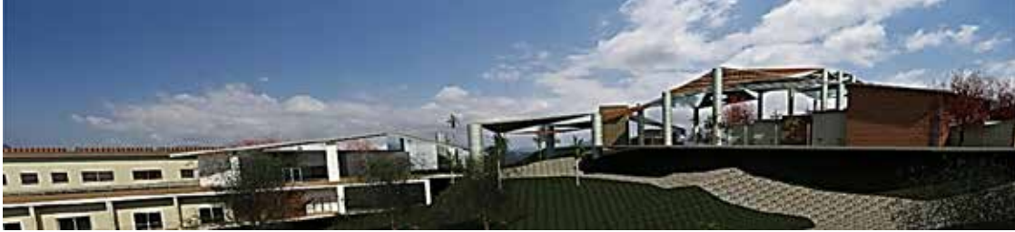
Figura 39. Vista de los techos en el conjunto (2018)
