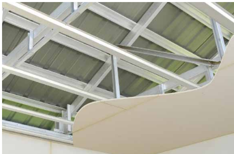
Figura 47: Detalle de cielo raso (2018)
