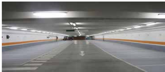
Figura 40: Suelo de concreto pulido. Fuente: www.pisosepoxicosindustriales.mx (2018)
