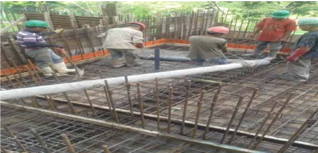
Foto 2. Vaciado de concreto en losa maciza.
