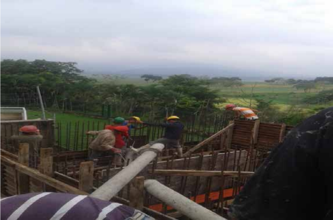
Foto 2. Vaciado de concreto en losa maciza.
