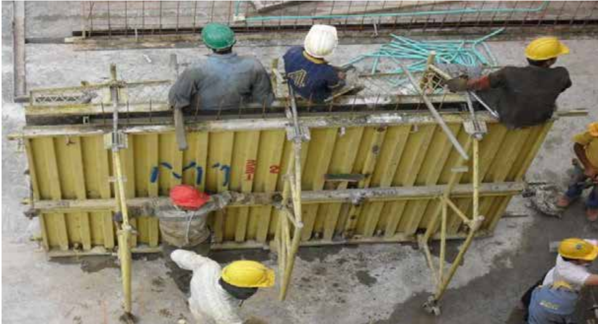
Foto 3. Espera en el vaciado de muros.
