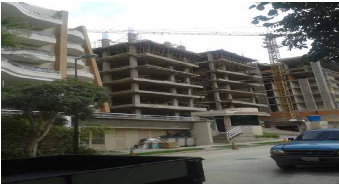
Foto 4. Vaciado de la 6ta losa y sus columnas.
